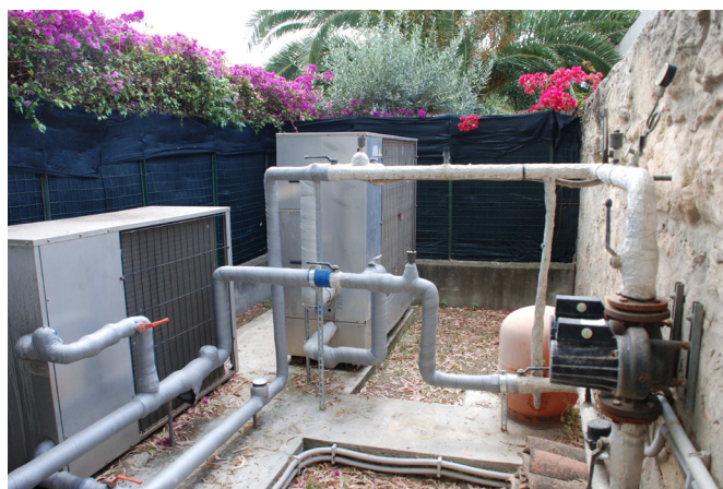
4. La collocazione delle pompe di calore nel resede.
