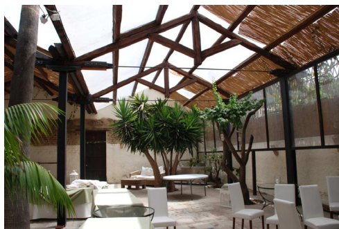
5. Strutture lignee negli spazi esterni.
